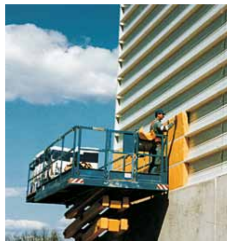
Zdjęcie 6 – Montaż płyt izolacyjnych URSA przy izolacji hal stalowych
