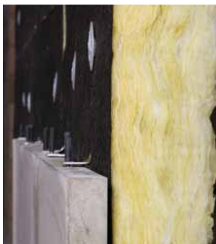
Zdjęcie 3 – Fasada wentylowana z okładziną kamienną
