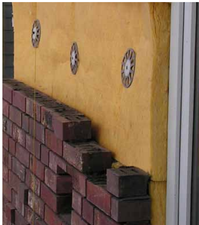
Zdjęcie 5 – Mur trójwarstwowy ze szczeliną wentylacyjną
