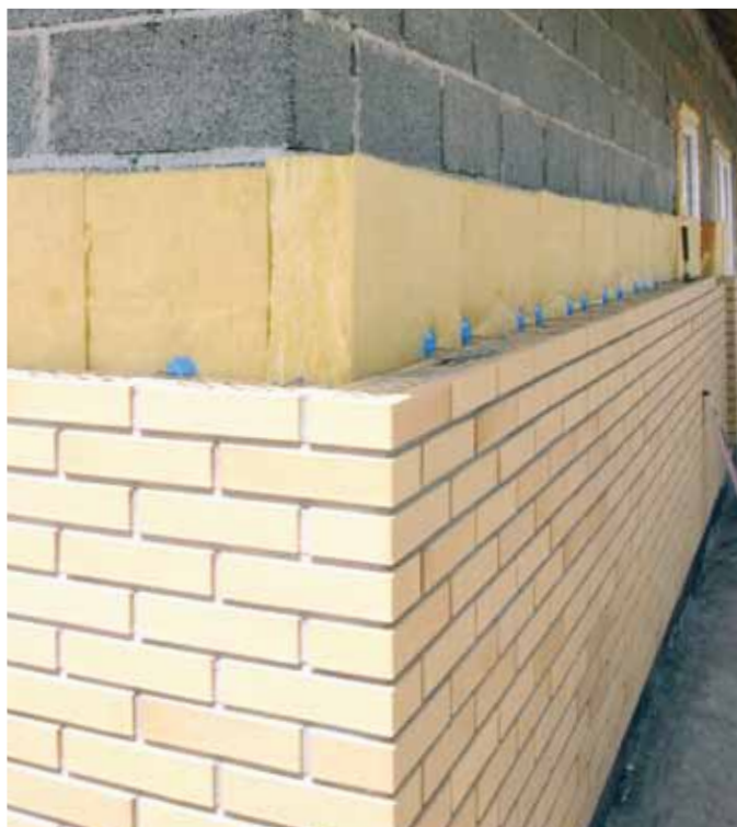
Zdjęcie 4 – Mur trójwarstwowy ze szczeliną wentylacyjną
