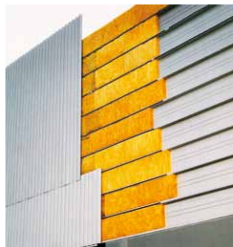
Zdjęcie 7 – Montaż płyt izolacyjnych URSA przy izolacji hal stalowych
